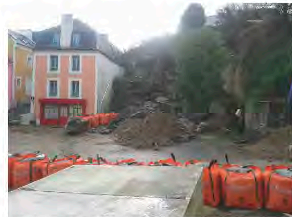
Eboulement à Sauzon en 2016 - Photo DDTM 56
